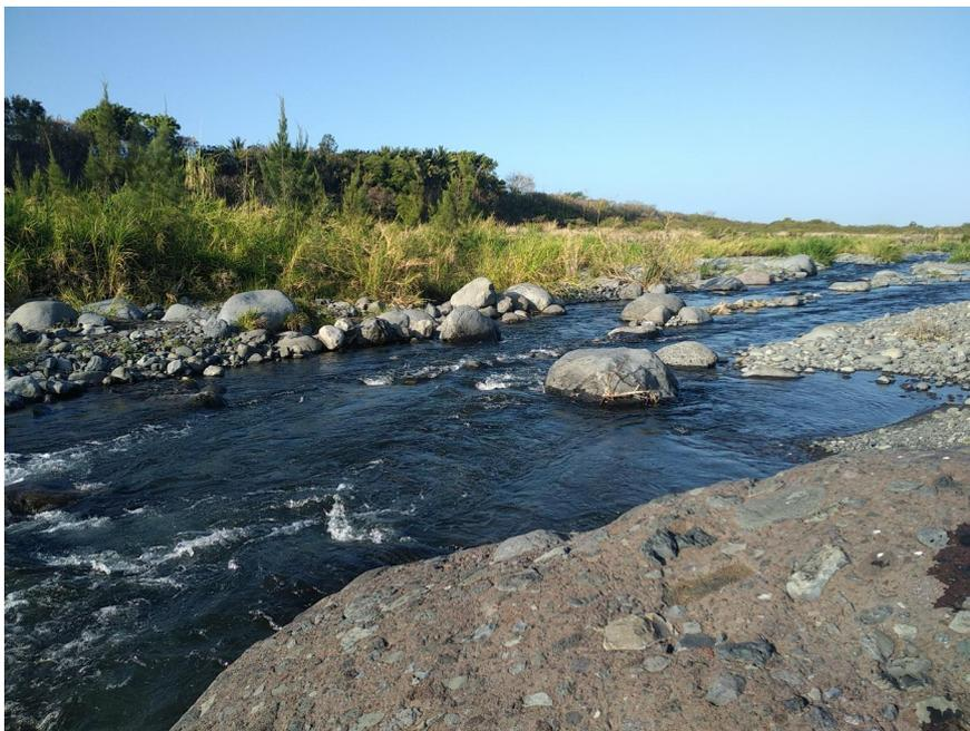
Figure 7 – Enrochements (centre de la photo) disposés sur le cours principal de la rivière pour dériver les eaux entre les canaux de l'ANP et l'APBRSE.
